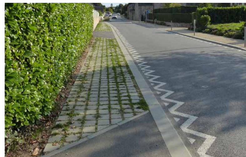
Exemple de pavés avec joints gazon sur la partie déjà rénovée - ( les joints seront aux normes PMR de 1.8 cm)
